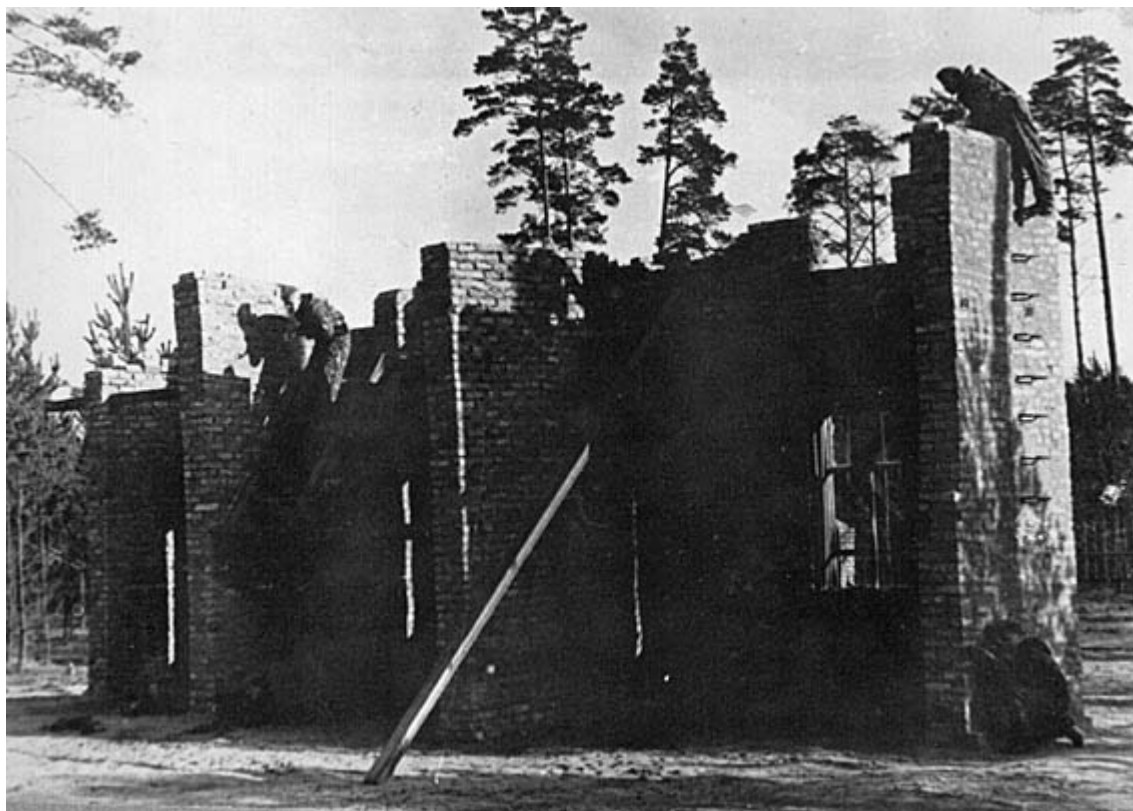
Рис. 4.1 способы преодоления полуразрушенного здания
