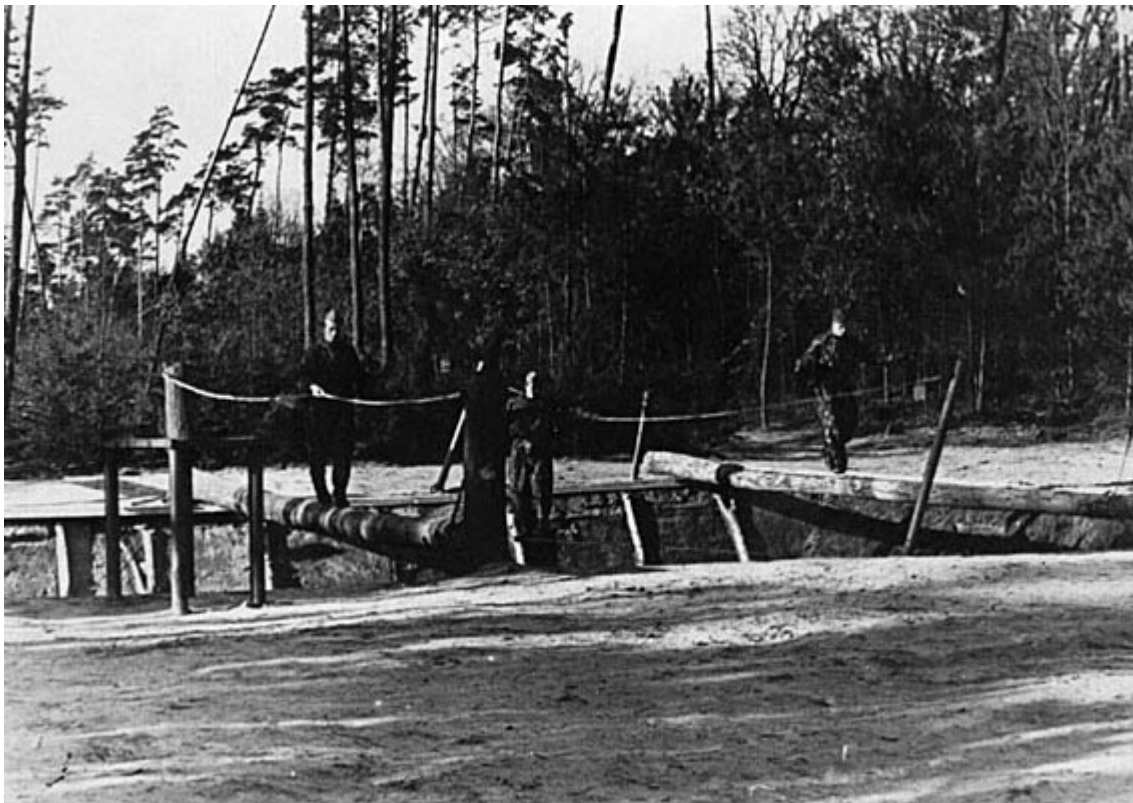
Рис. 21 ров, средства и способы его преодоления длина - 10 м, глубина - 2,5 м
