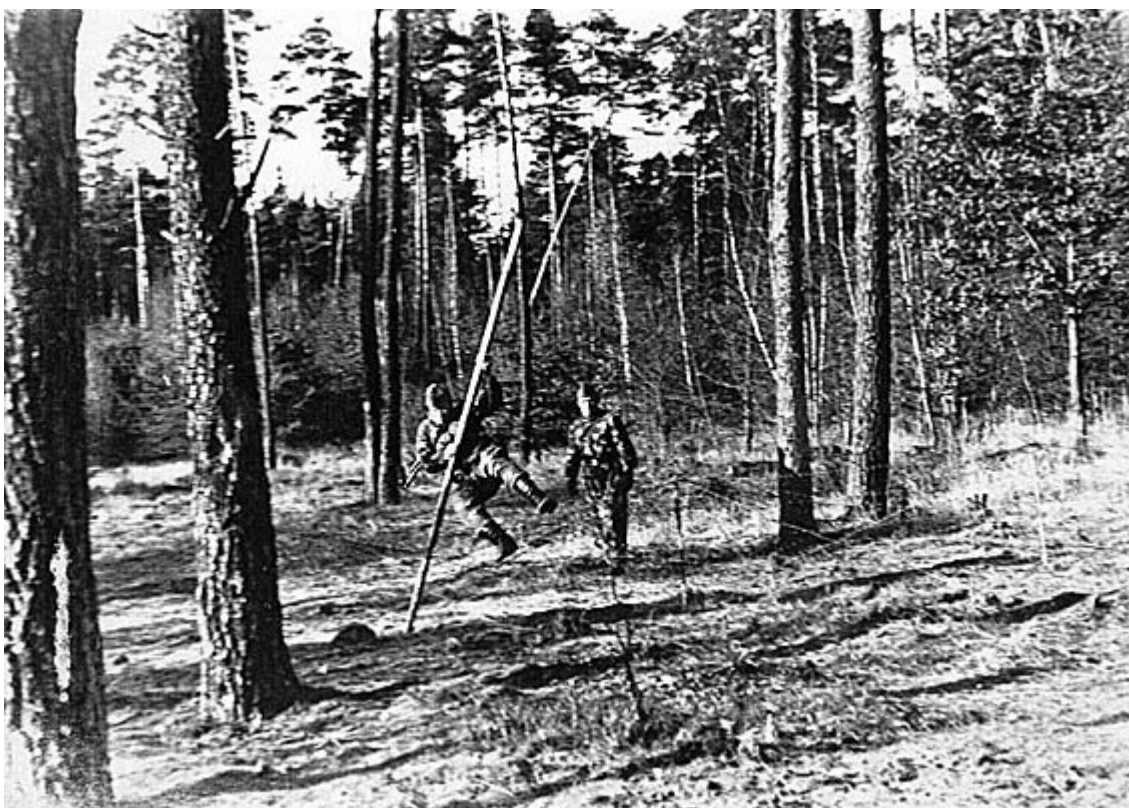
Рис. 15 проволочный забор на высоких металлических кольях и способ его преодоления длина - 18 м, ширина - 3 м, высота - 1,1 м
